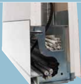
Metalen plint op de wand
